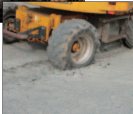
Verdichtung – eine Folge häufiger Befahrungen
