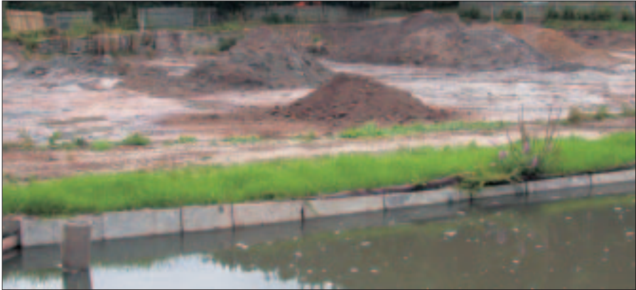
Baggergut – Entschlammung eines verlandeten Teiches
